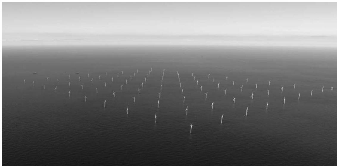
Figura 4 Parco Eolico Offshore di Horns Rev - Danimarca. (Fonte Elsam A/S).
